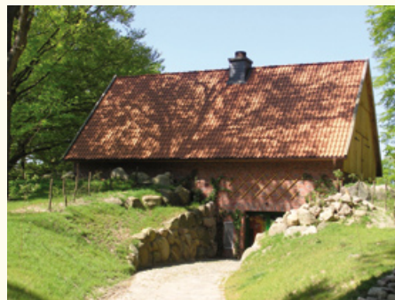
Das Heizwerk von Wilsede
