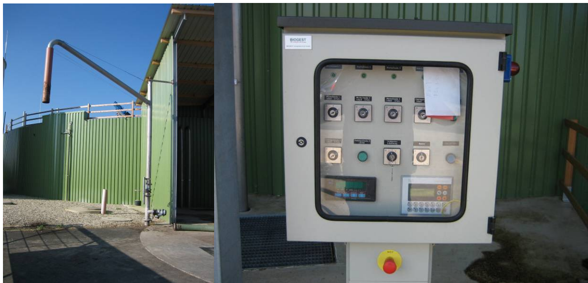
Abbildung 41: Gärrestübergabestelle mit Steuerungskasten für die Güllepumpe
