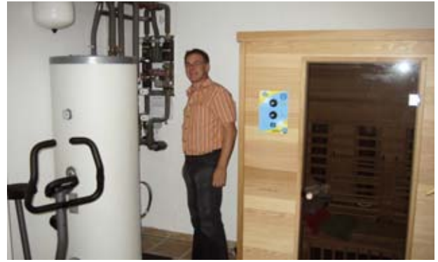
Abb. 54: Wärmeübergabestation im Haus der Familie Deichfuß – Der ehemalige Heizölkeller ist nun mit einer Sauna ausgestattet
