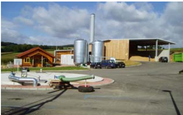
Abb. 53: Güllevorgrube (Vordergrund), Warte, Nahwärmenetz-Pufferspeicher, Holzhackschnitzelheizwerk und -lagerhalle (Hintergrund)
