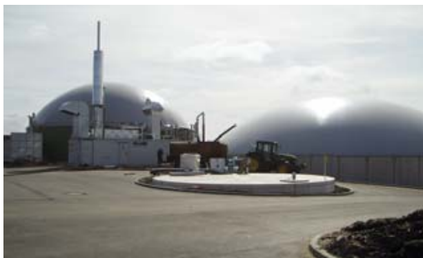
Abb. 49: Güllevorgrube, Fermenter und Nachgärbehälter
