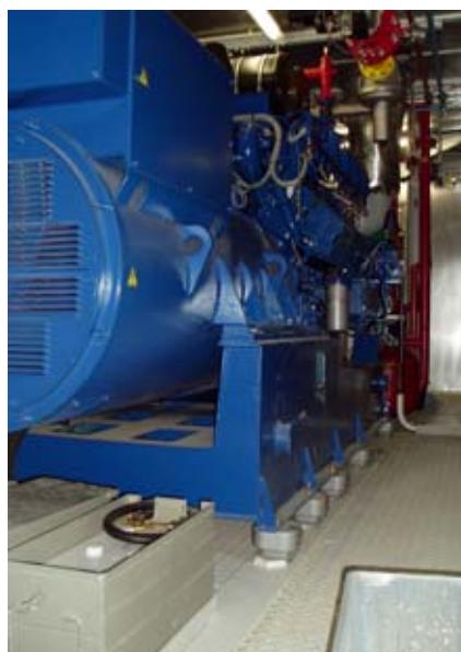
Abb. 52: Motor- Generator- Kombination des Blockheiz- kraftwerkes (BHKW)
