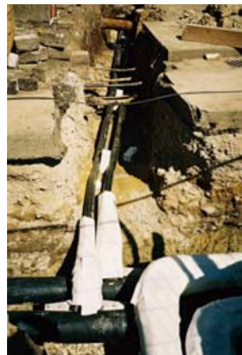
Abb. 17: Verlegung des Nahwärmenetzes in Jühnde
