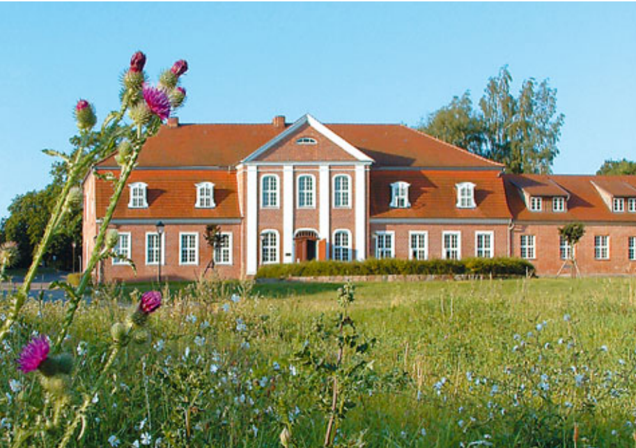
Das Dienstgebäude der FNR in Gülzow
