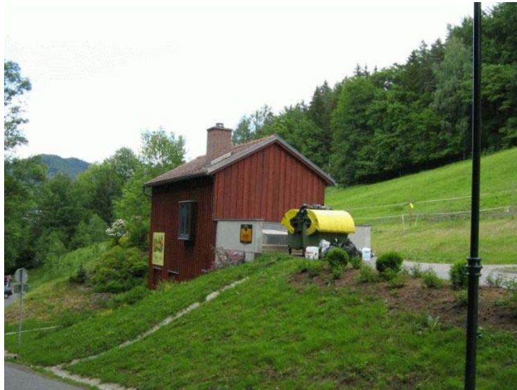
Abbildung 30 Heizhaus, 100 kW, mit unterirdischem HHS-Lager Jugendgästehaus Bruck, Steiermark.
