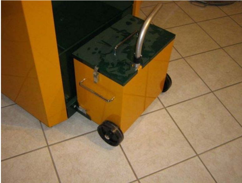
Abbildung 29 Aschekasten an einem Biomassekessel
