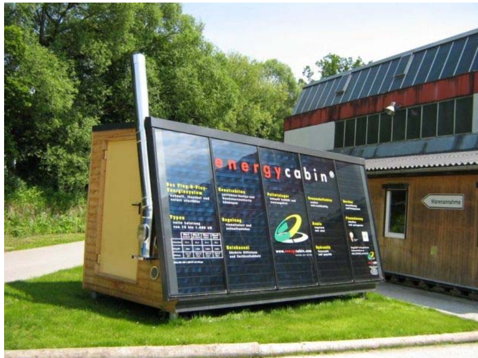
Abbildung 49 Kompakt-Heizzentrale inkl. Pelletslager Hersteller: Fa. EnergyCabin, Österreich
