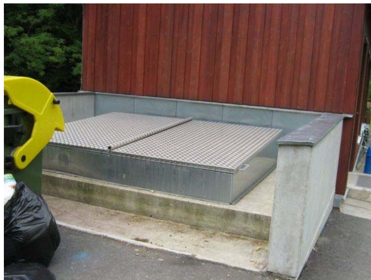
Abbildung 31 HHS-Brennstofflager-Abdeckung. Jugendgästehaus Bruck, Steiermark
