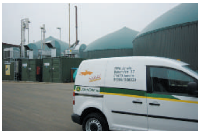
Biogasanlage u. a. mit dem Container für die Veredelung des Rohbiogases zu Kraftstoffqualität (Foto: Region Aktiv Wendland-Elbetal)
