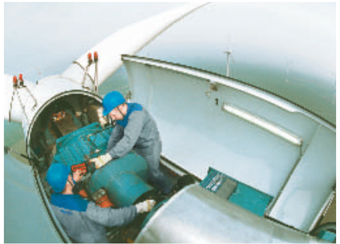
Spezialisten von Voith Industrial Services Wind bei Instandhaltungsarbeiten am Antriebsstrang einer WEA
