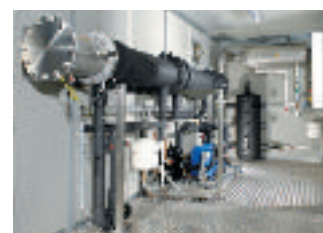
Abbildung 1: Siloxa-Gaskühlung
