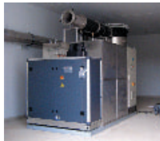
Abbildung 2: Siloxa-Gaswaschtrockner
