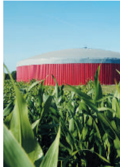
Biogasanlage in Sollerup
