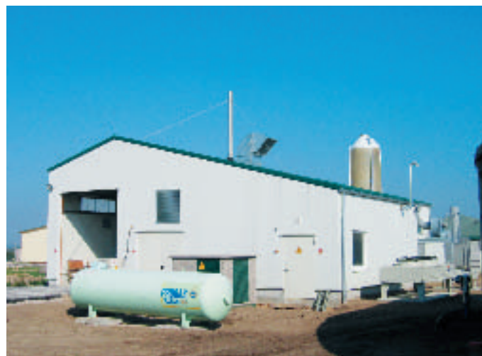
Zum Anfahren der Biogasanlage wird oft Propangas verwendet (Abb.: in-Trust AG)
