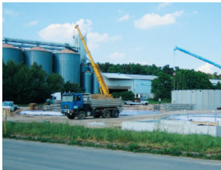
Eine penible Überwachung der Bauphase ist unerlässlich (Abb.: in-Trust AG)
