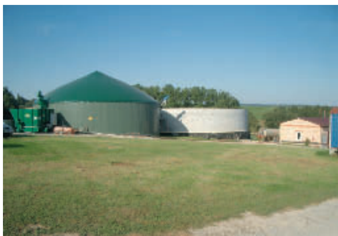
Standard-Anlage im Arbeitskreis Biogas ist eine 190 kW-Nawaro-Nassfermentationsanlage
