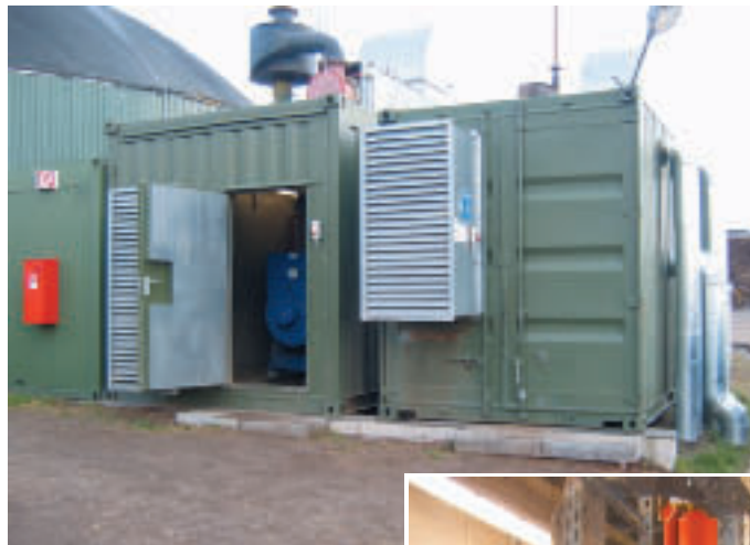
Aus Kostengründen wurde in Wiesbaum ein viel zu kleiner Container für das BHKW aufgestellt
