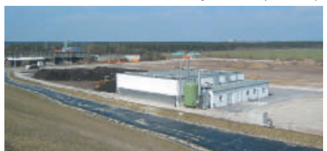
Seit 2003 betriebene Trockenfermentationsanlage in München (Foto: Bekon)
