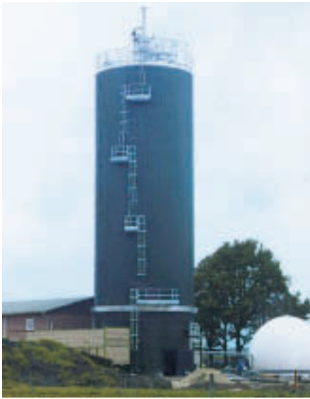
Die neue OWS-Trockenfermentationsanlage in Bassum (Abb.: OWS)
