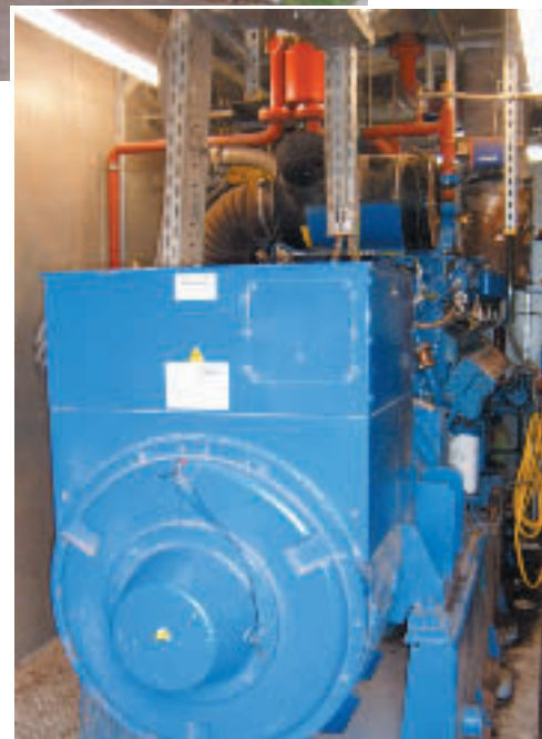
Aus Kostengründen wurde in Wiesbaum ein viel zu kleiner Container für das BHKW aufgestellt
