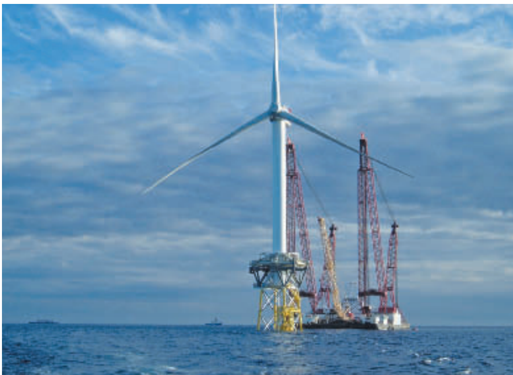
Eine der ersten Offshore WEA. Installationen von REpower vor der schottischen Küste
