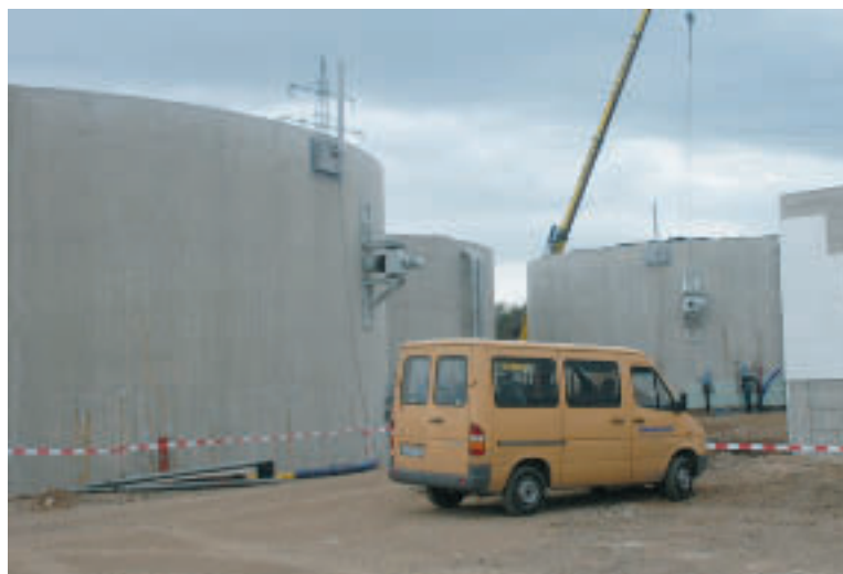
Drei Nachfermenter sorgen für optimierte Gasausbeute. Zum Zeitpunkt der Aufnahme befand sich die Anlage noch im Bau (Foto: fnp)
