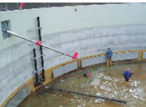
Fermenter mit Schrägachsührwerk, innen liegenden, im unteren Bereich angebrachten Plattenheizregistern aus V 4A Stahl sowie einem oben aufgetragenen Schutzanstrich aus speziellen Epoxidharzen
