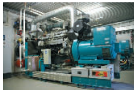
Schnell Zündstrahlmotor ES2656 mit Turbocompounder
