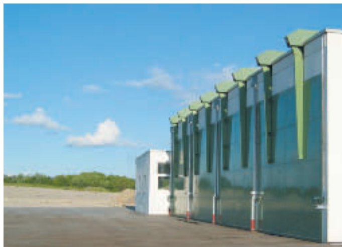
Die Fermenter müssen so gestaltet sein, dass sie mit Frontladern oder anderen Geräten problemlos beschickt werden können
