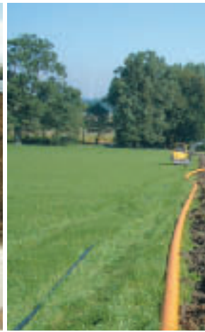
Eine 3,6 km lange Biogasleitung BHKW direkt am Kreishaus Stein
