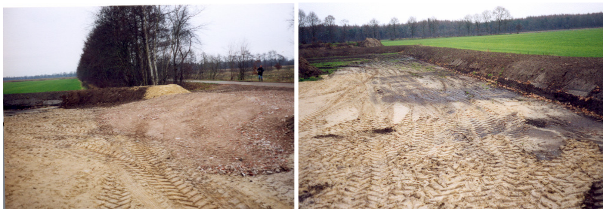
Abb. 12: Umwallung einer Biogasanlage in der Fertigung
