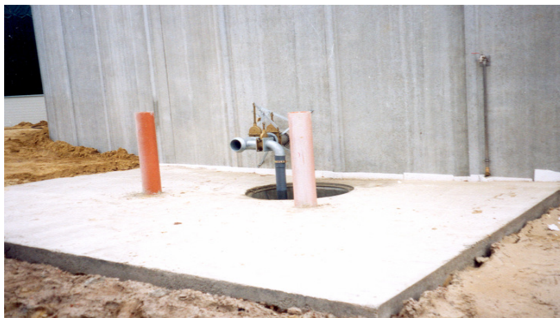
Abb. 6: Befestigter Abgabebereich mit Auffangbehälter
