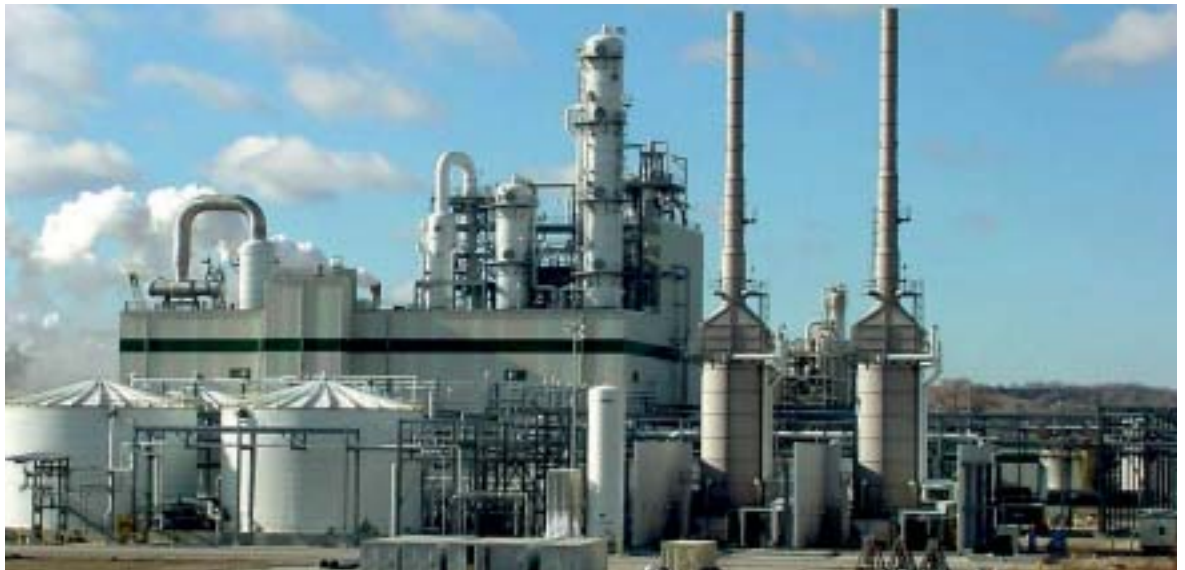
Abb 4. Teilansicht der Cargill-Dow-Polylactid-Anlage in Blair, Nebraska, USA. (Mit freundlicher Genehmigung von Cargill Dow LLC)
