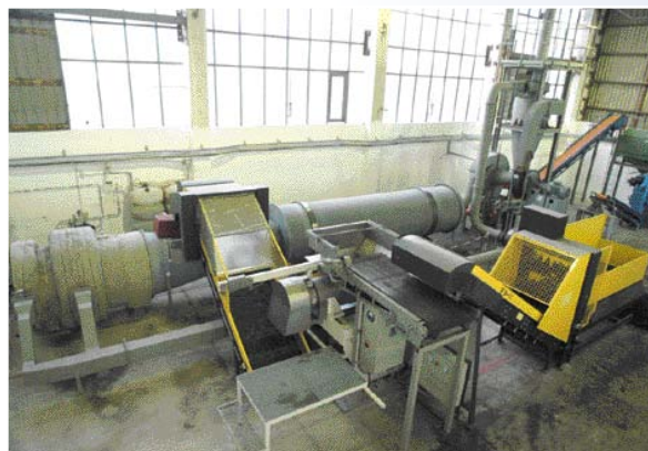
Prototypanlage in Grundshagen/Klütz Prototype facility in Grundshagen/Klütz
